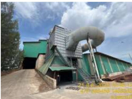
รูปที่ 2 ระบบดักฝุ่นแบบถุงกรอง
